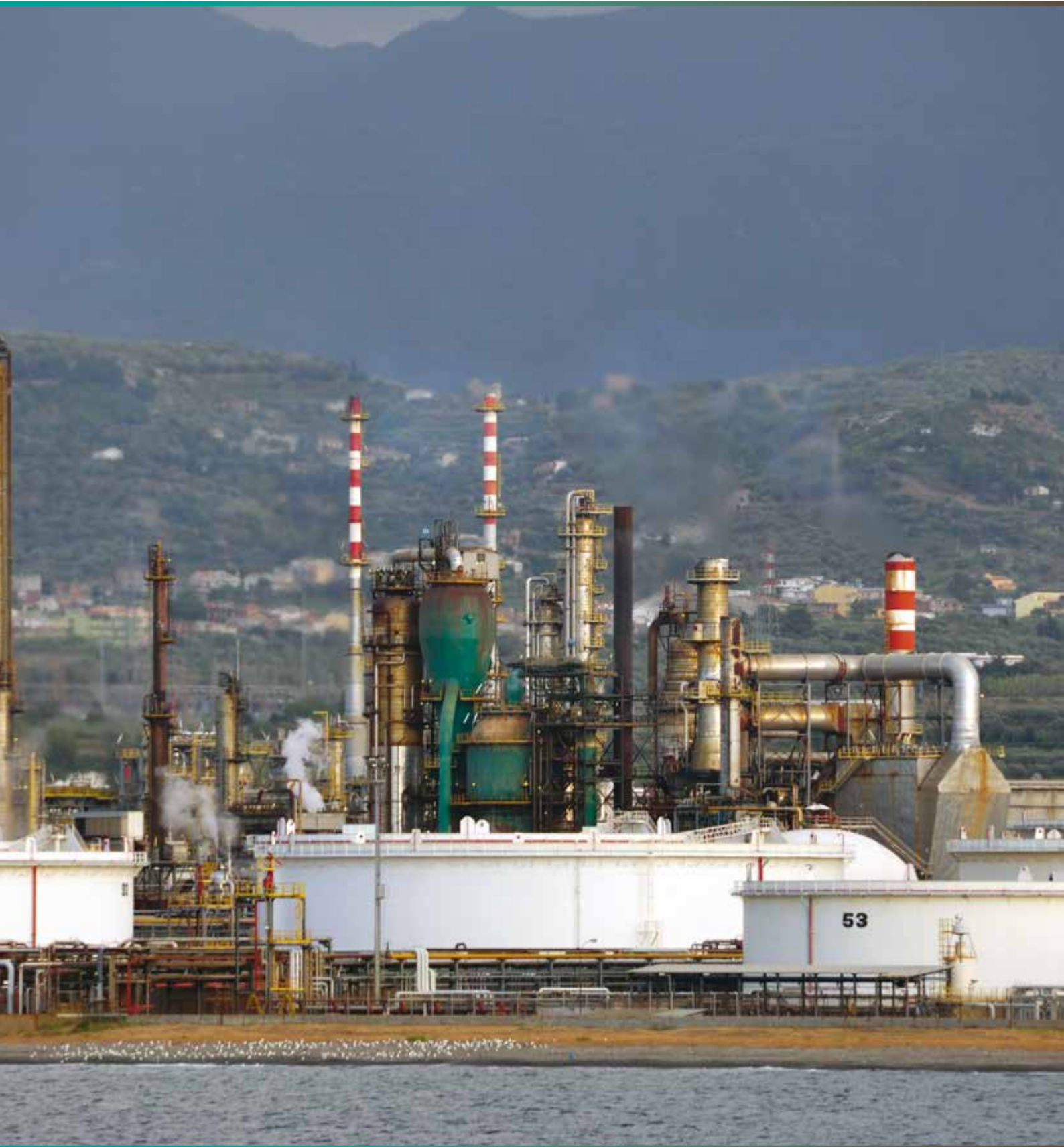
Foto 10.19 Impianti industriali Fonte MATTM Luca Grassi
