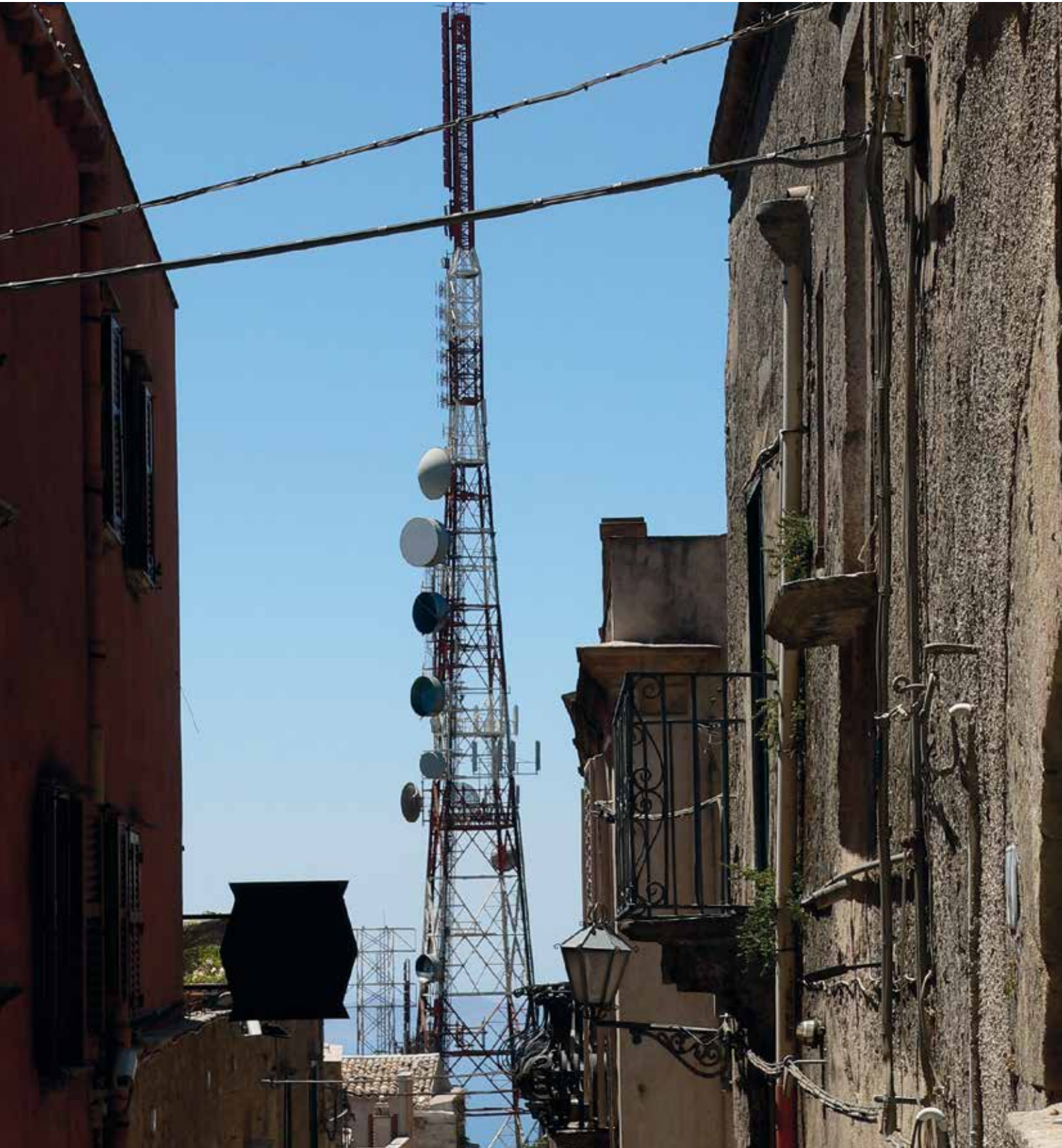
Foto 3.10 Ripetitore in ambiente urbano Fonte ISPRA Franco Iozzoli
